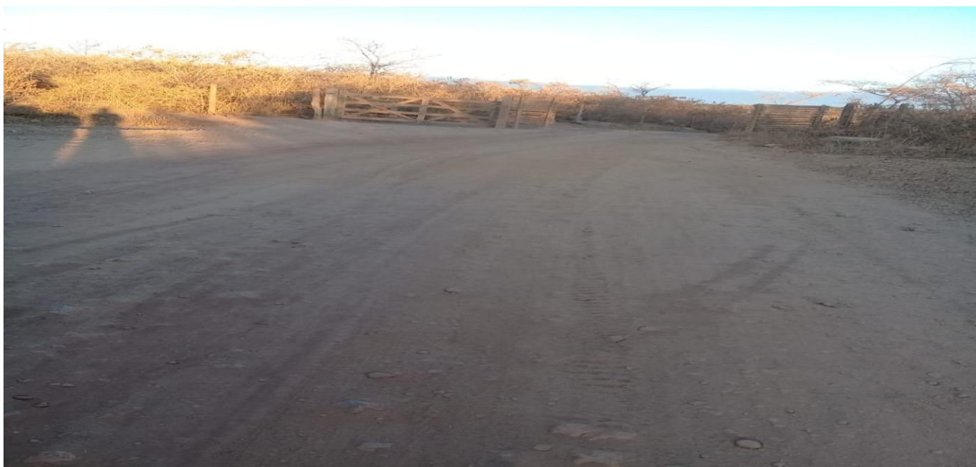
FOTO N° 02: IMAGEM DO TRECHO A SER PAVIMENTADO – ANTES DA OBRA
