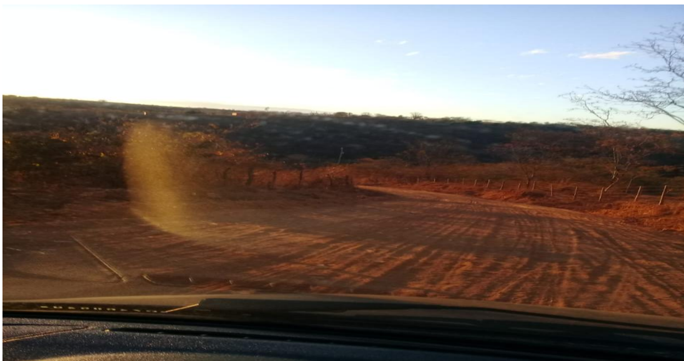
FOTO N° 04: IMAGEM DO TRECHO A SER PAVIMENTADO – ANTES DA OBRA
