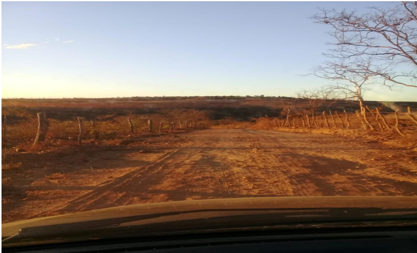
FOTO N° 03: IMAGEM DO TRECHO A SER PAVIMENTADO – ANTES DA OBRA
