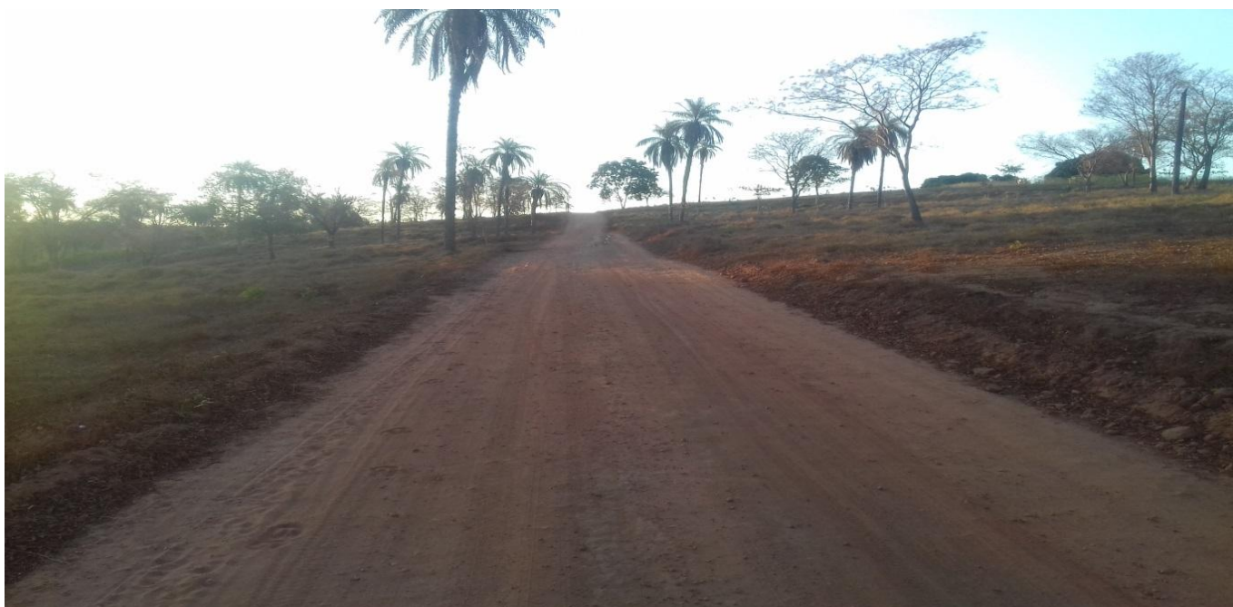
FOTO N° 05: IMAGEM DO TRECHO A SER PAVIMENTADO – ANTES DA OBRA
