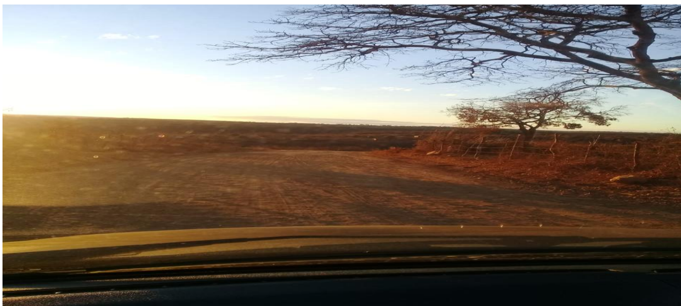
FOTO N° 01: IMAGEM DO INICIO DO TRECHO A SER PAVIMENTADO – ANTES DA OBRA
