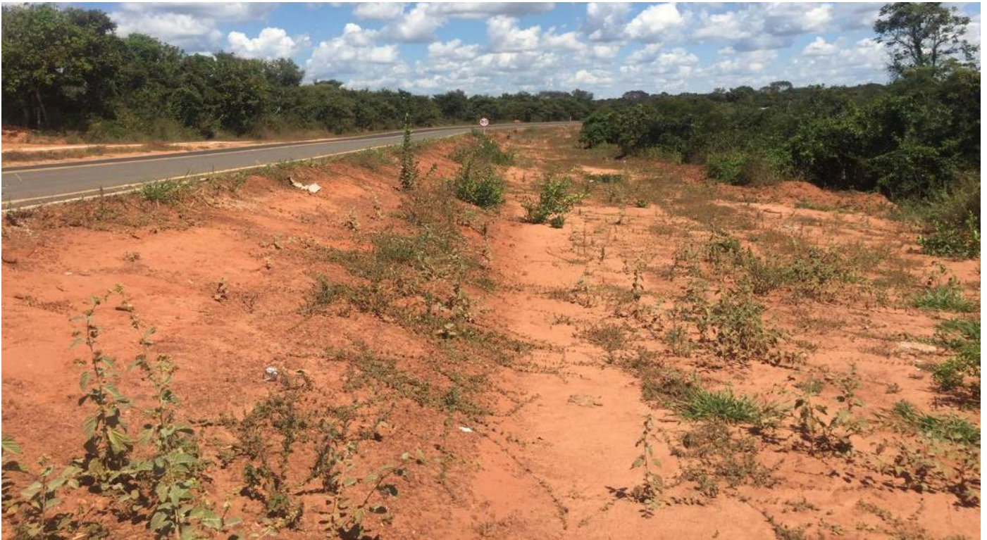
FOTO N° 06: IMAGEM DO TRECHO MARGINAL DA RODOVIA VALDOMIRO PEREIRA DE SOUZA – ANTES DA OBRA
