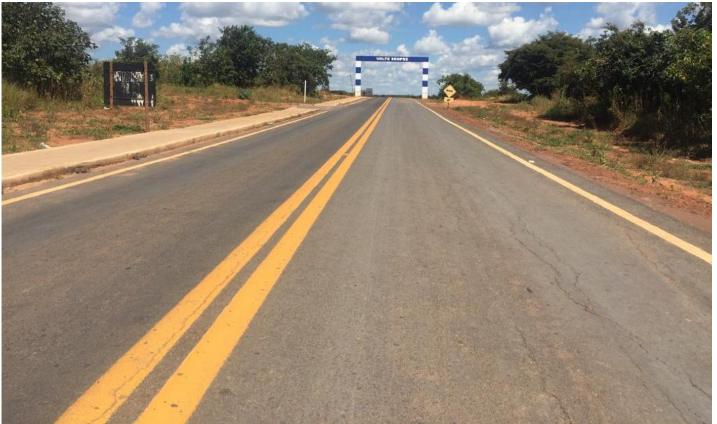
FOTO Nº 01: IMAGEM DO INICIO DO TRECHO MARGINAL DA RODOVIA VALDOMIRO PEREIRA DE SOUZA – ANTES DA OBRA
