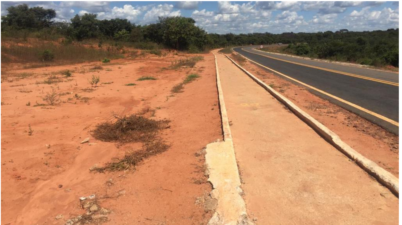
FOTO Nº 05: IMAGEM DO TRECHO MARGINAL DA RODOVIA VALDOMIRO PEREIRA DE SOUZA – ANTES DA OBRA
