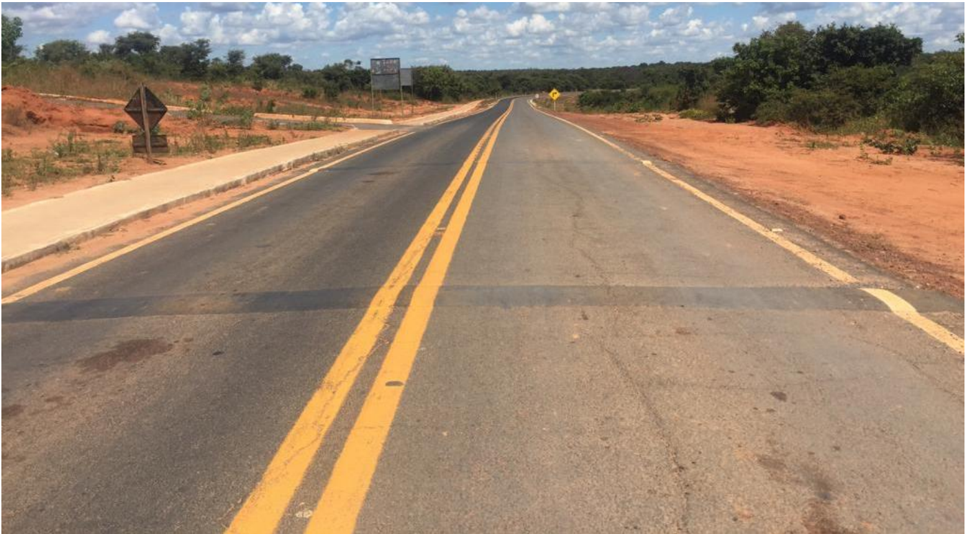
FOTO Nº 04: IMAGEM DO TRECHO MARGINAL DA RODOVIA VALDOMIRO PEREIRA DE SOUZA – ANTES DA OBRA
