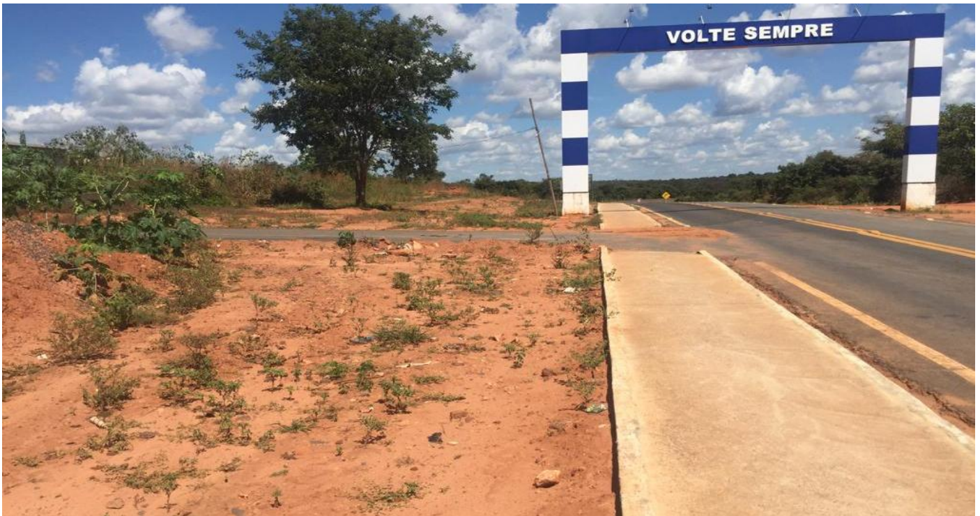
FOTO N° 02: IMAGEM DO TRECHO MARGINAL DA RODOVIA VALDOMIRO PEREIRA DE SOUZA – ANTES DA OBRA
