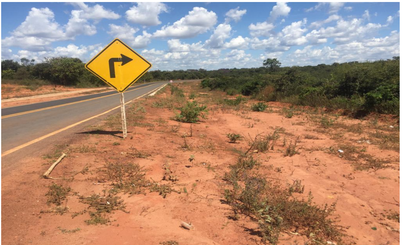
FOTO N° 06: IMAGEM DO TRECHO MARGINAL DA RODOVIA VALDOMIRO PEREIRA DE SOUZA – ANTES DA OBRA
