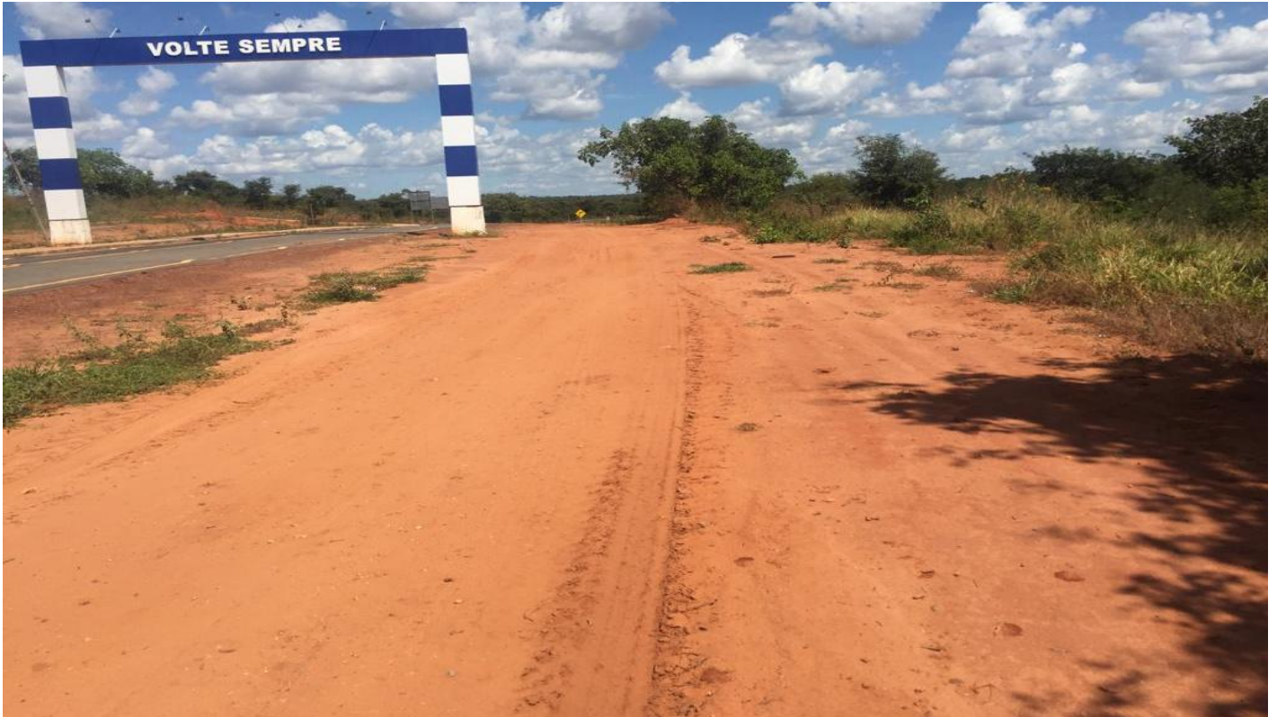
FOTO N° 03: IMAGEM DO TRECHO MARGINAL DA RODOVIA VALDOMIRO PEREIRA DE SOUZA – ANTES DA OBRA
