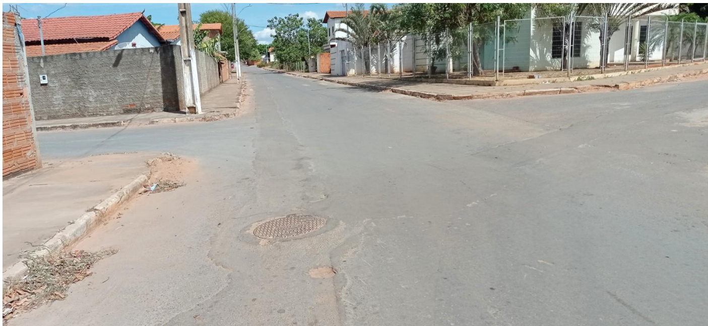
FOTO N° 05: RUA SEBASTIÃO ALVES DE AQUINO COM NOSSA SENHORA APARECIDA – IMAGEM ANTES DA OBRA
