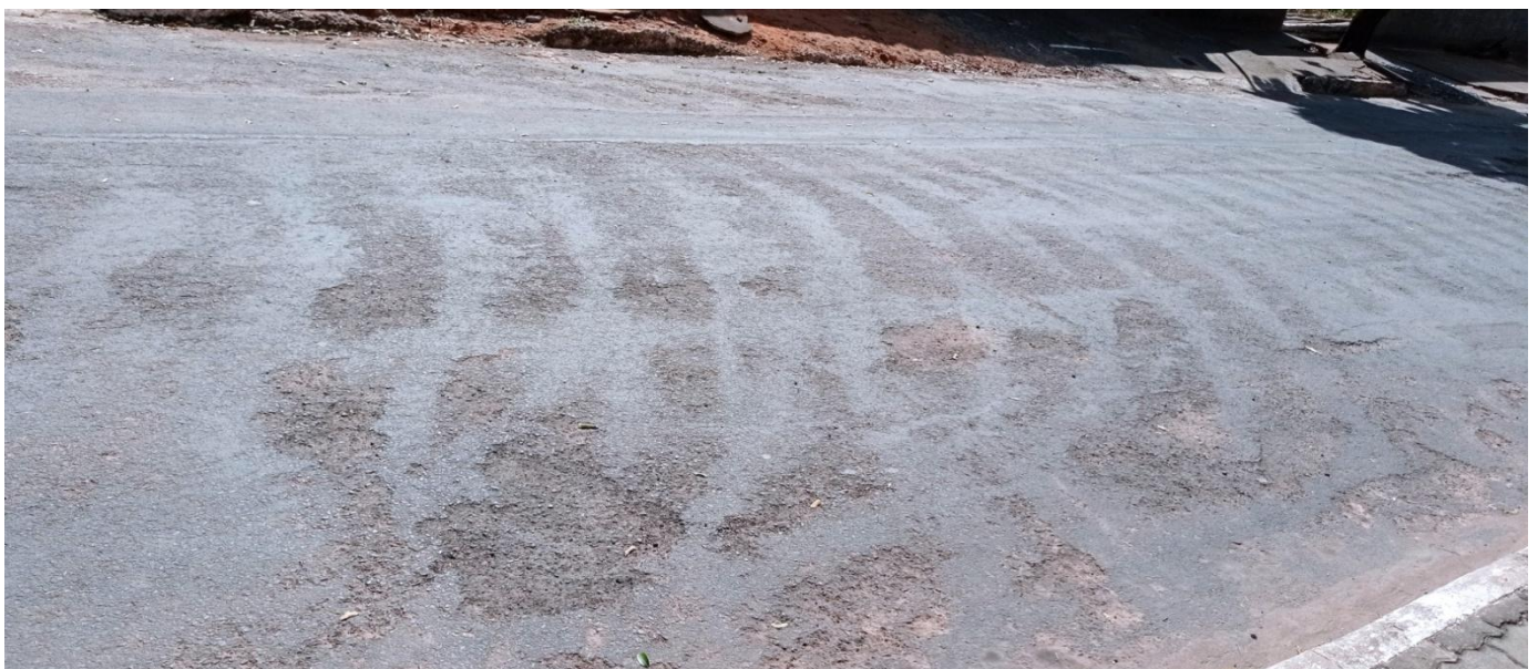
FOTO Nº 02: RUA SEBASTIÃO ROCHA – IMAGEM ANTES DA OBRA
