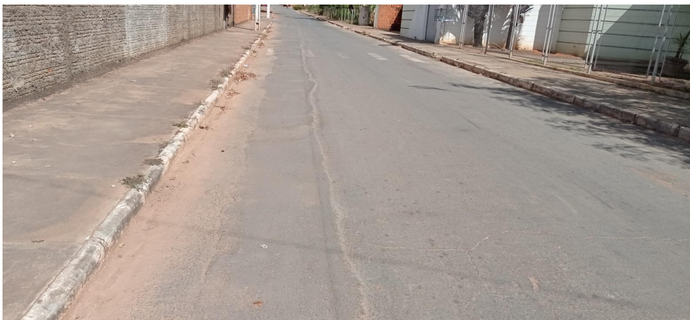
FOTO N° 04: RUA SEBASTIÃO ALVES DE AQUINO – IMAGEM ANTES DA OBRA
