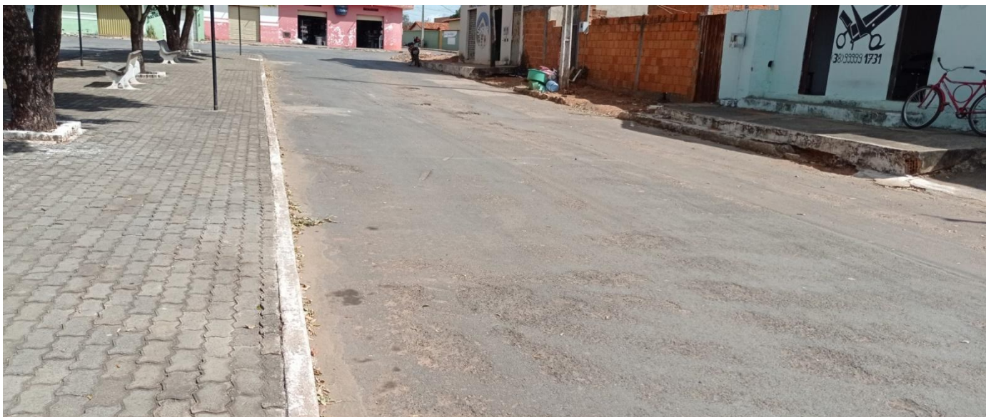
FOTO Nº 01: RUA SEBASTIÃO ROCHA – IMAGEM ANTES DA OBRA
