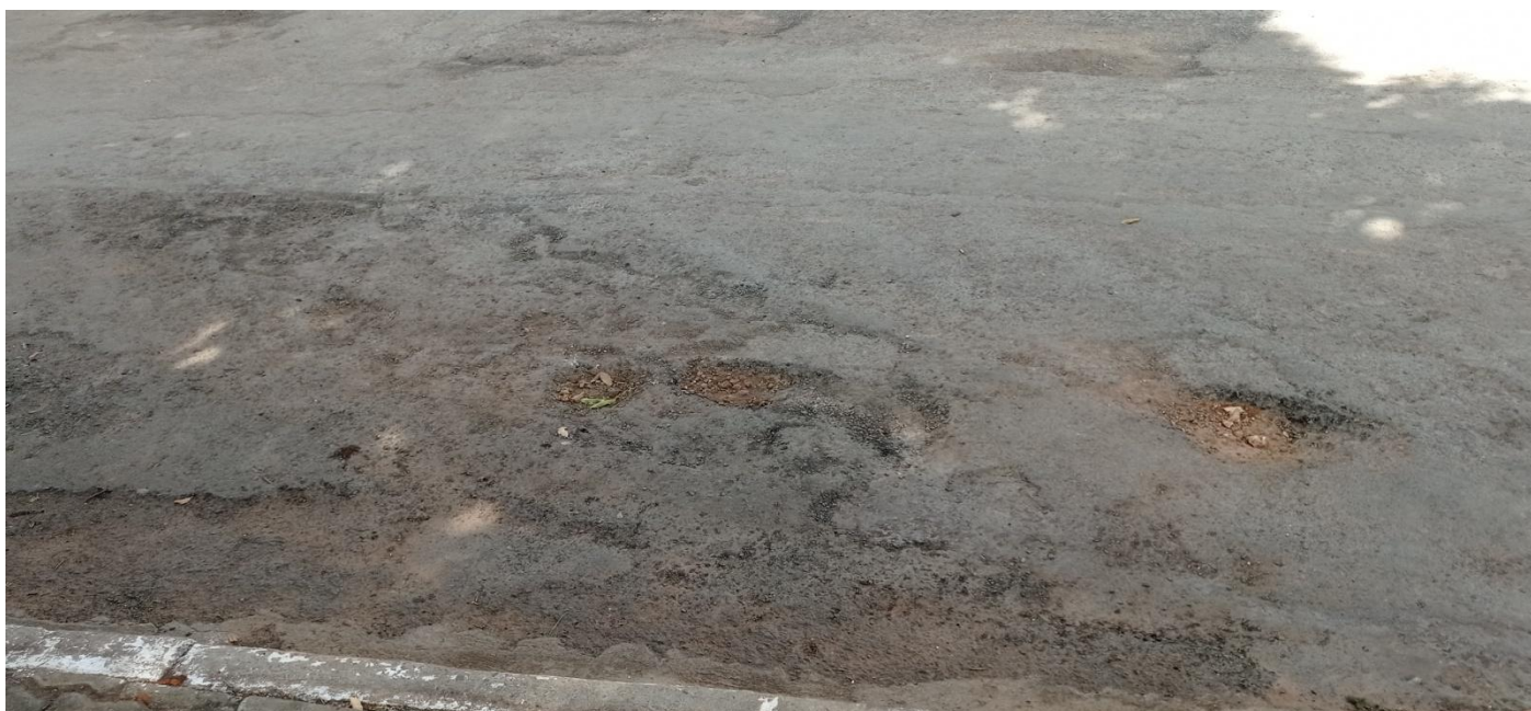
FOTO N° 03: RUA SEBASTIÃO ROCHA – IMAGEM ANTES DA OBRA
