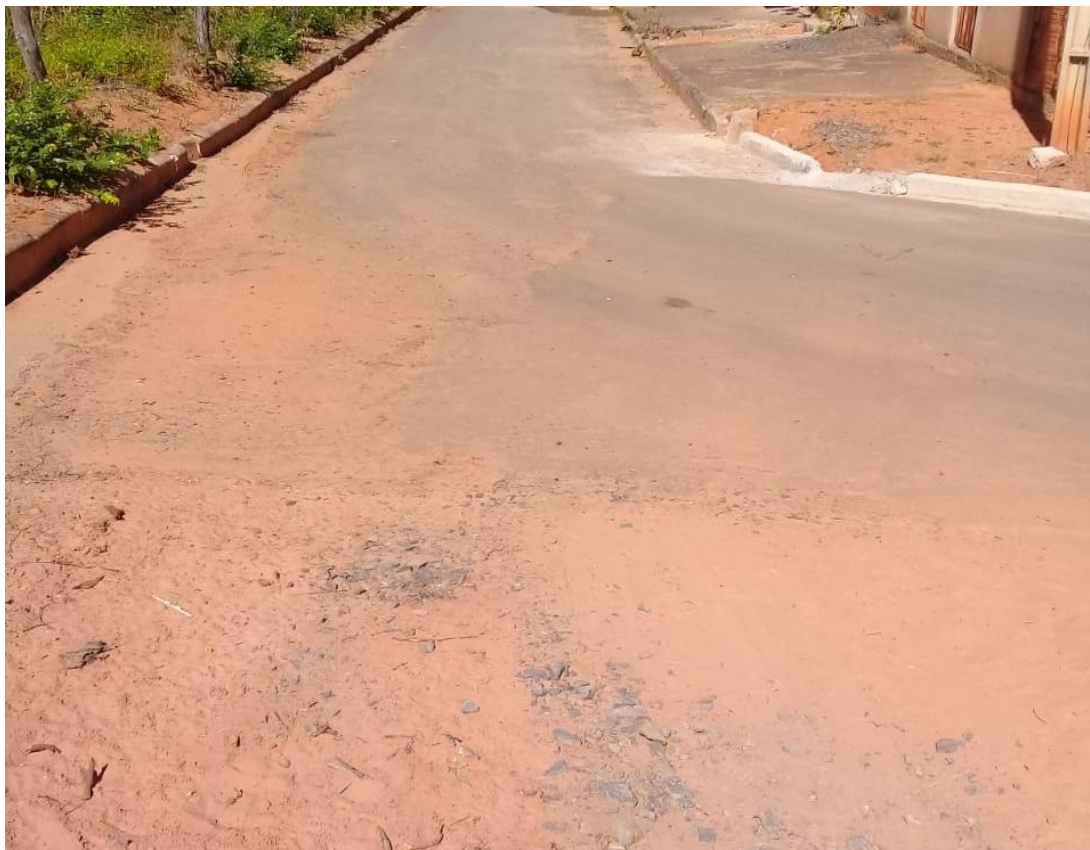
FOTO N° 02: ENTRADA PINDAIBA DO ARROZ – IMAGEM ANTES DA OBRA
