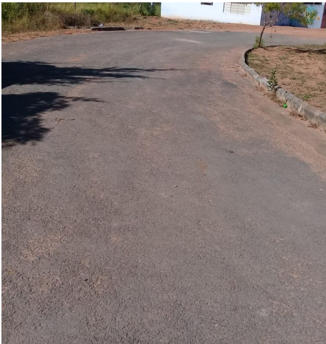
FOTO Nº 07: ROTATÓRIA PINDAIBA DO ARROZ – IMAGEM ANTES DA OBRA
