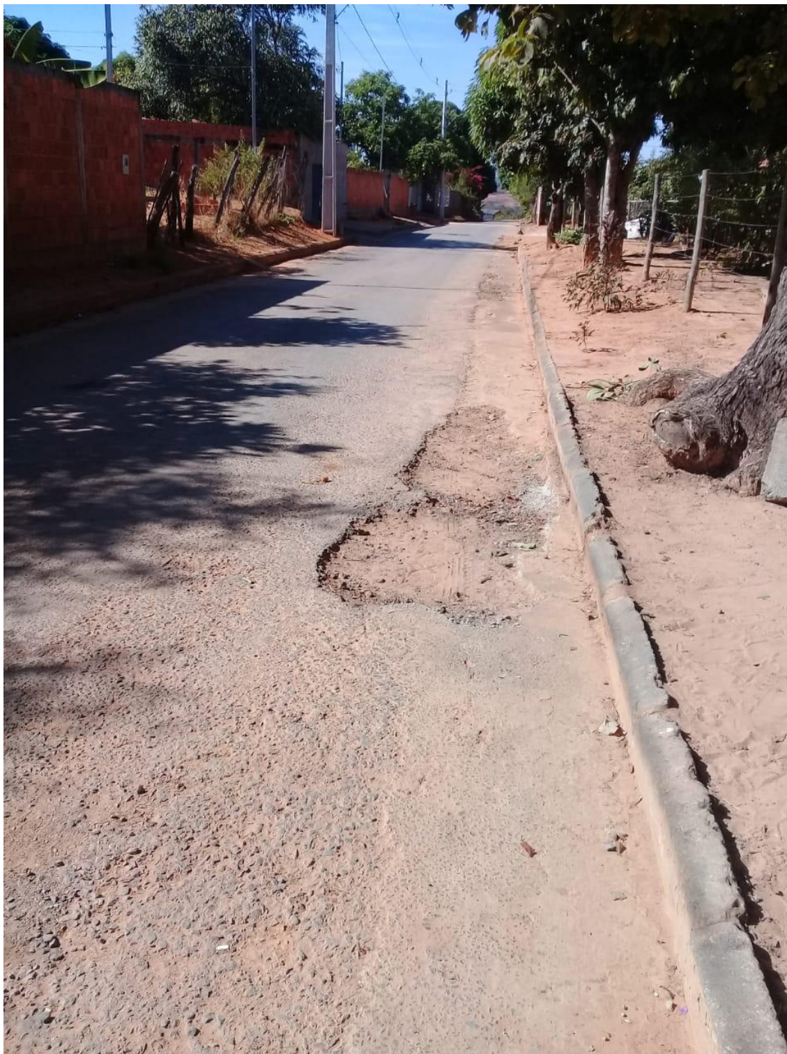
FOTO N° 06: ENTRADA PINDAIBA DO ARROZ – IMAGEM ANTES DA OBRA
