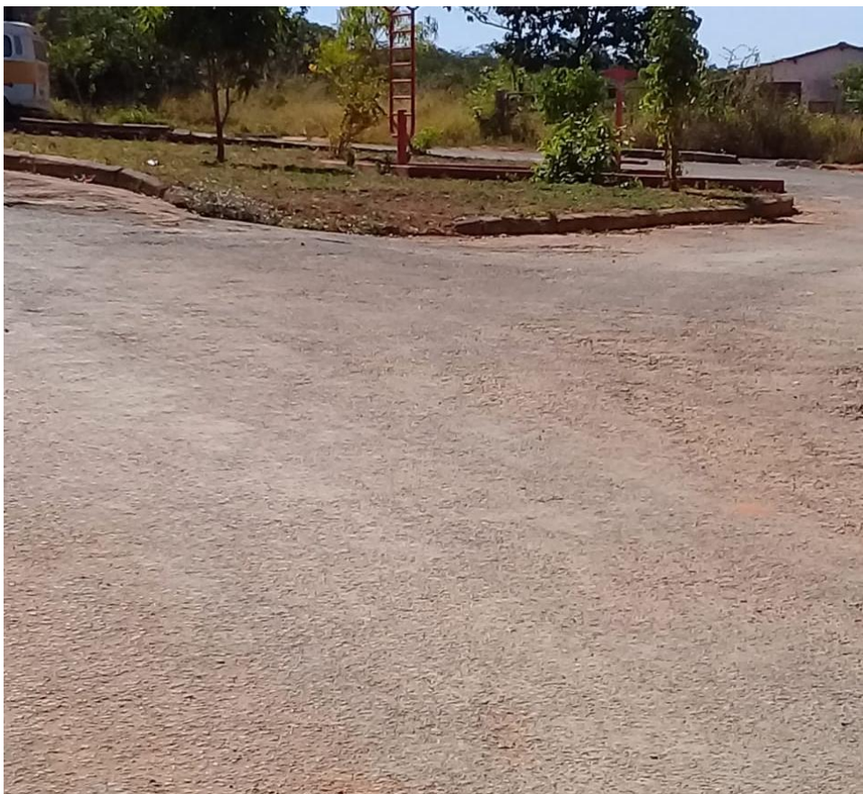
FOTO N° 09: ROTATÓRIA PINDAIBA DO ARROZ – IMAGEM ANTES DA OBRA
