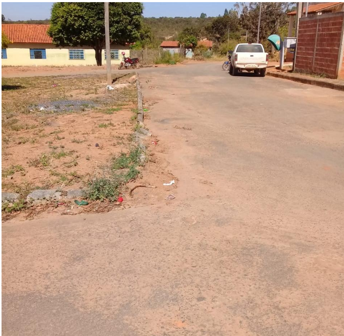
FOTO Nº 10: ROTATÓRIA PINDAIBA DO ARROZ – IMAGEM ANTES DA OBRA
