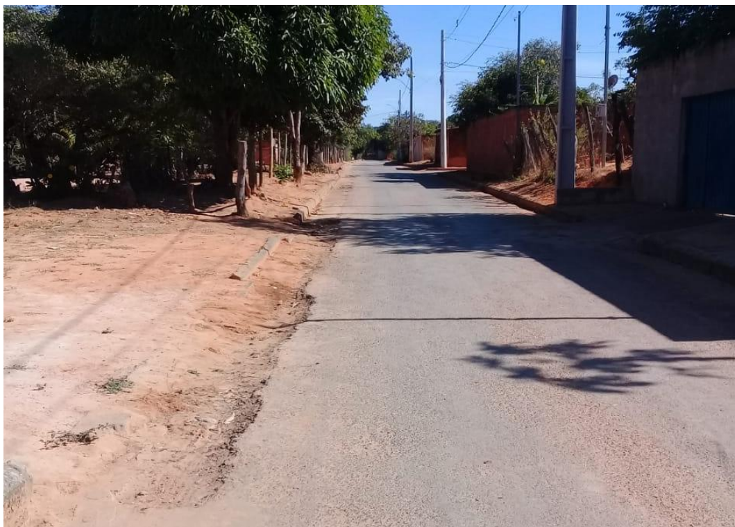
FOTO N° 04: ENTRADA PINDAIBA DO ARROZ – IMAGEM ANTES DA OBRA
