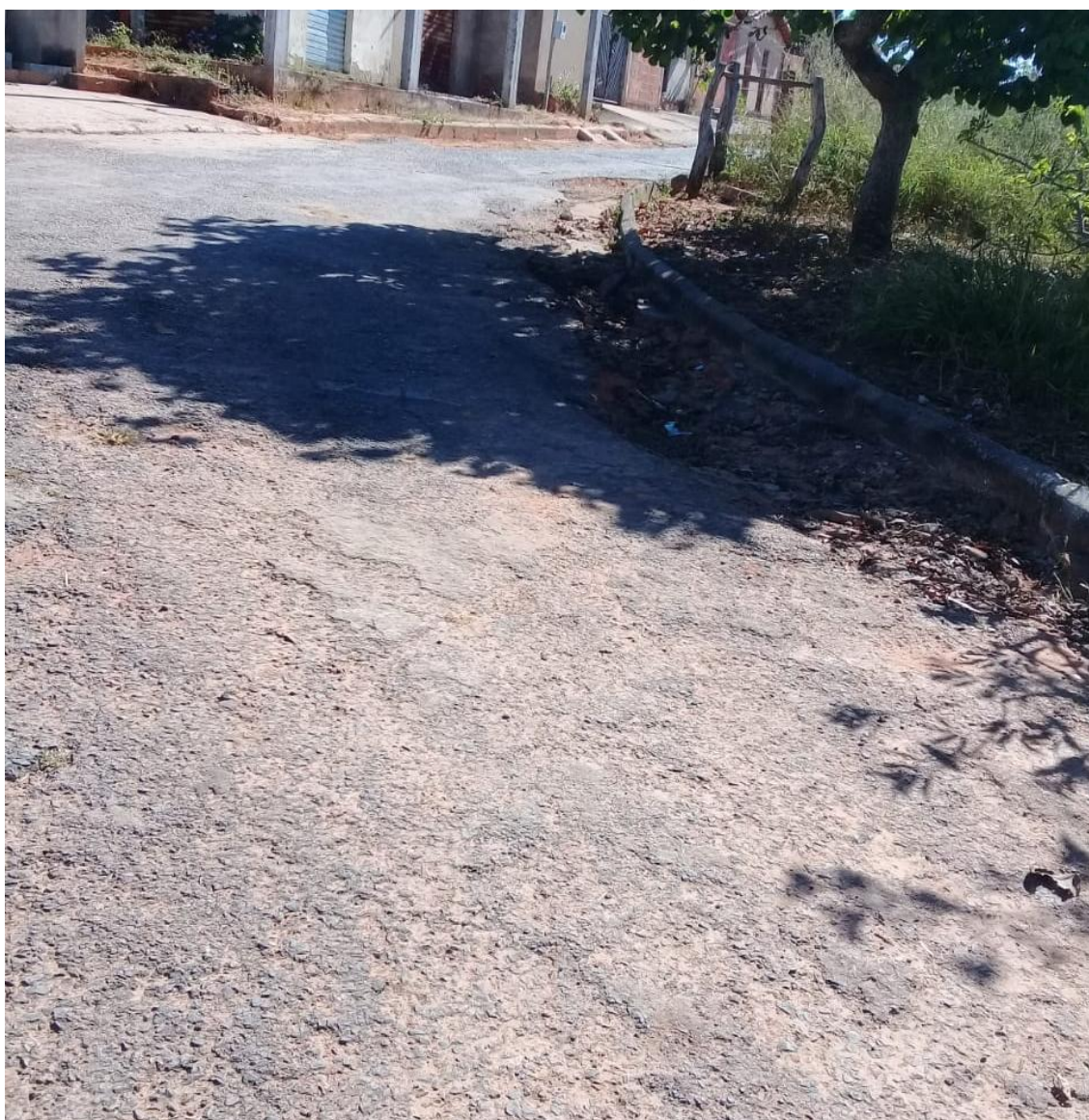
FOTO Nº 11 ROTATÓRIA PINDAIBA DO ARROZ – IMAGEM ANTES DA OBRA
