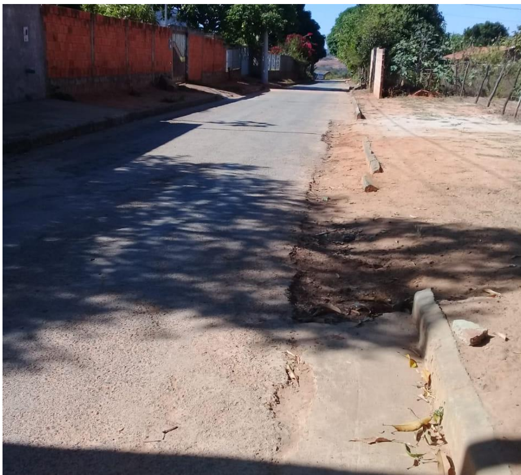
FOTO N° 05: ENTRADA PINDAIBA DO ARROZ – IMAGEM ANTES DA OBRA
