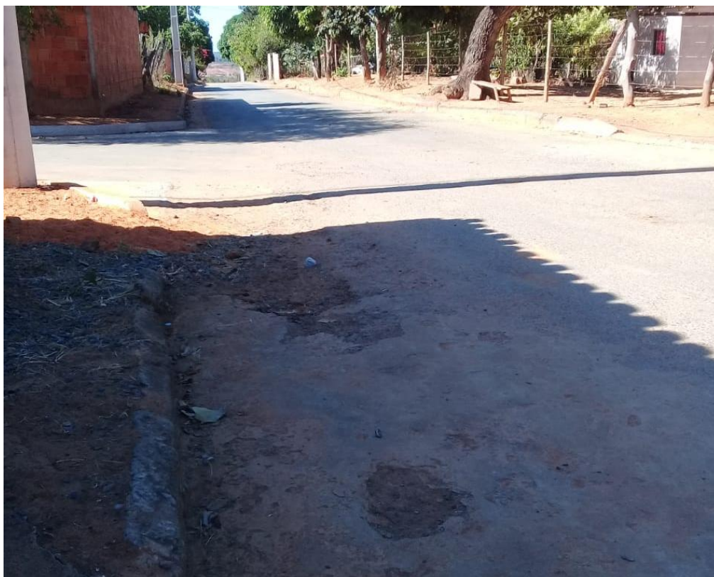
FOTO N° 03: ENTRADA PINDAIBA DO ARROZ – IMAGEM ANTES DA OBRA
