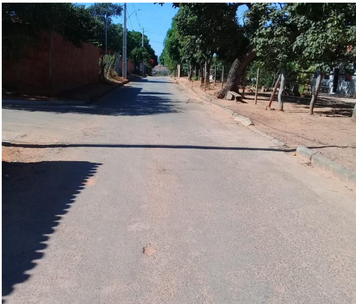
FOTO Nº 01: ENTRADA PINDAIBA DO ARROZ – IMAGEM ANTES DA OBRA
